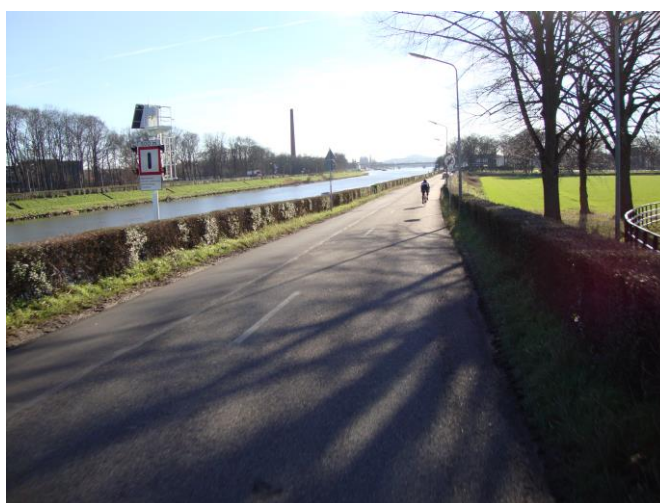
Zicht op de Sluisdijk richting het noordwesten
