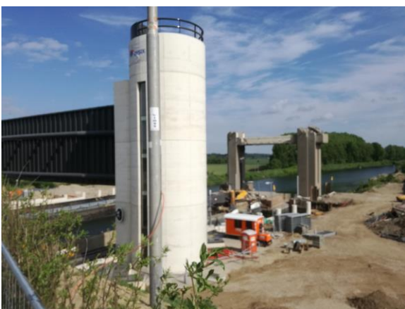
Nieuwe kersluis Julianakanaal (rechts sloop oude sluis)
